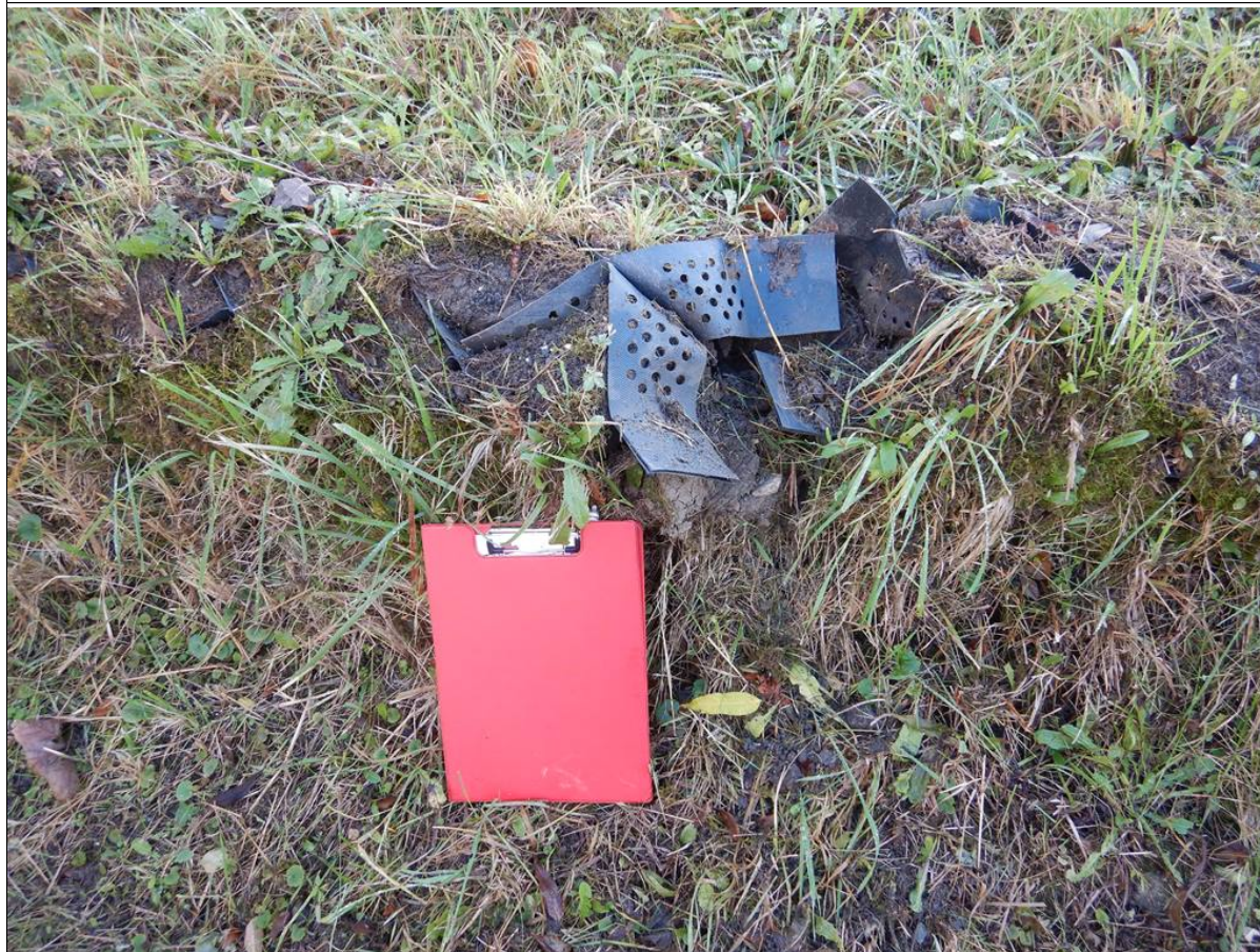
Uszkodzona geokrata
